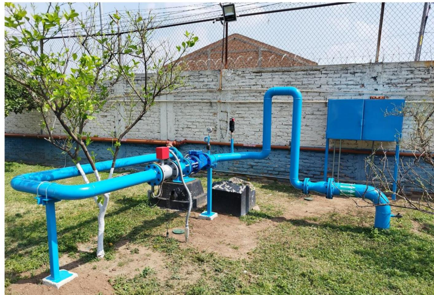
Realizamos levantamiento, selección, suministro e instalación del medidor adecuado para cumplir con la norma NMX-AA-179-SCFI-2018.
